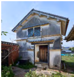
明治前期建造の土蔵
