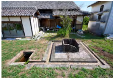
煉瓦造の排水枡を備えた深井戸
