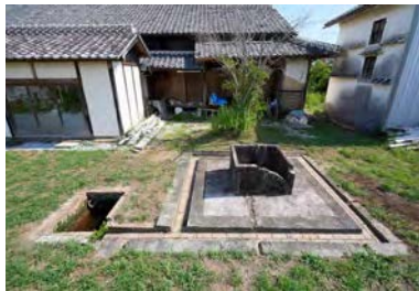
煉瓦造の排水枡を備えた深井戸
