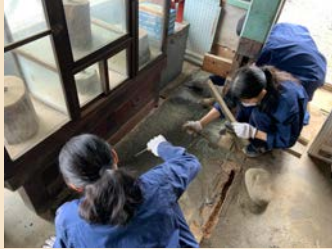
土間コンの骨材には、割れた瓦をさらに砕いて再利用しました！
