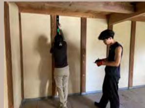
柱と床の傾きを測っていきます。
