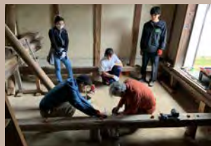
新たに束を立て床の傾きを整えます
