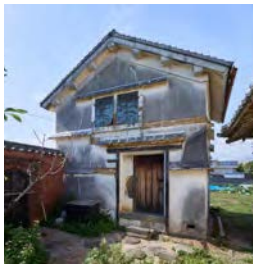
明治前期建造の土蔵
