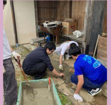
草が生えないようにセメントを敷設
