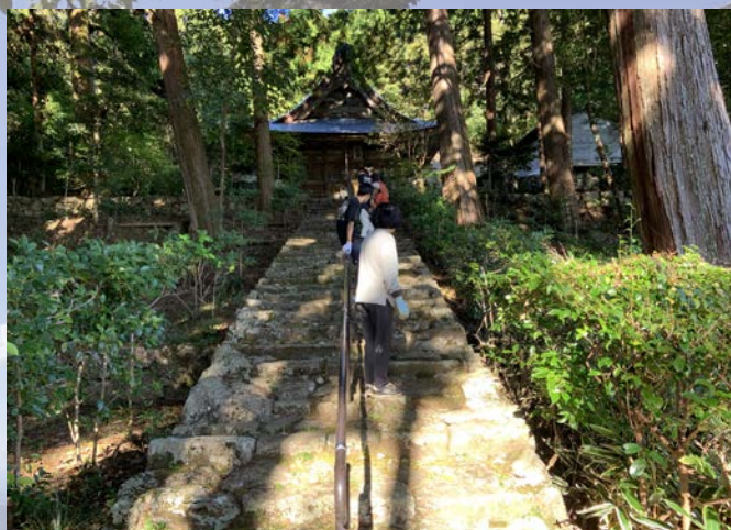
本堂の前から車が入るところまで、階段を瓦リレーで下ろします!!
