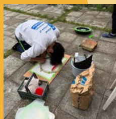
中段の型枠を製作
