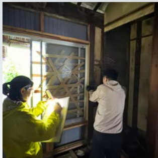
柱の寸法を測りながら図面に書き込みます
