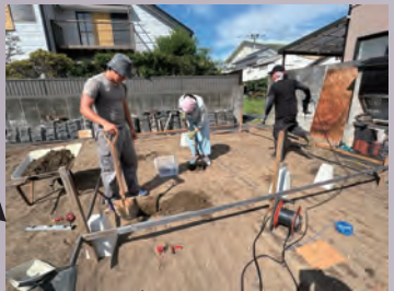
束石を入れる位置に深さ 30センチの穴を掘ります
