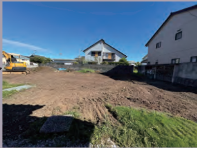
裏庭は建物を解体したままのため土が多い状態でした そこで土をすきとって、適切な水勾配をつくりました
