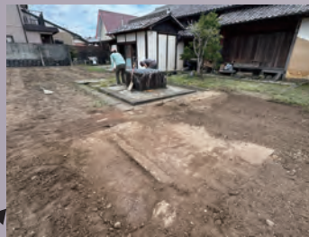
土の下にあった煉瓦や洗い出しの土間、 建物の基礎などが見えてきました!
