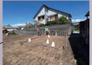
建物の範囲を囲むように杭をうち、建築 場所を確認していきます
