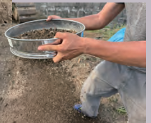
土には砂利が多く混ざっていた ので、ふるいをかけて碎石とし て再利用します!
