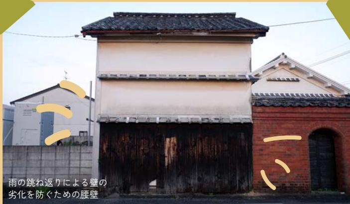
雨の跳ね返りによる壁の劣化を防ぐための腰壁
