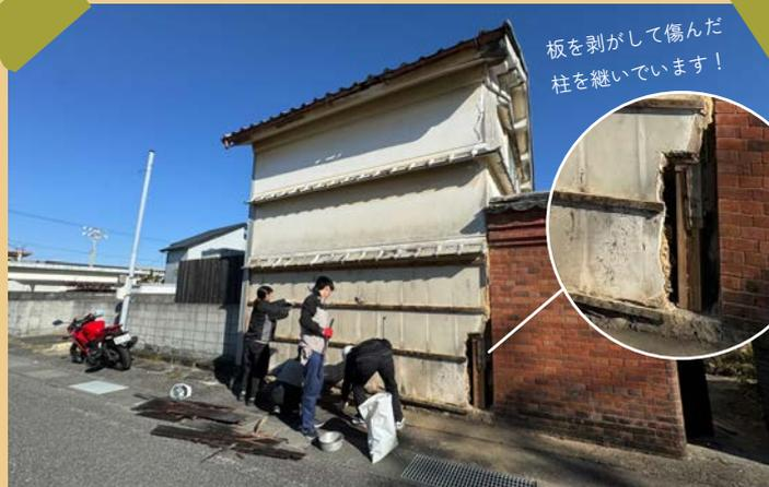
板を剥がして傷んだ柱を継いでいます!
